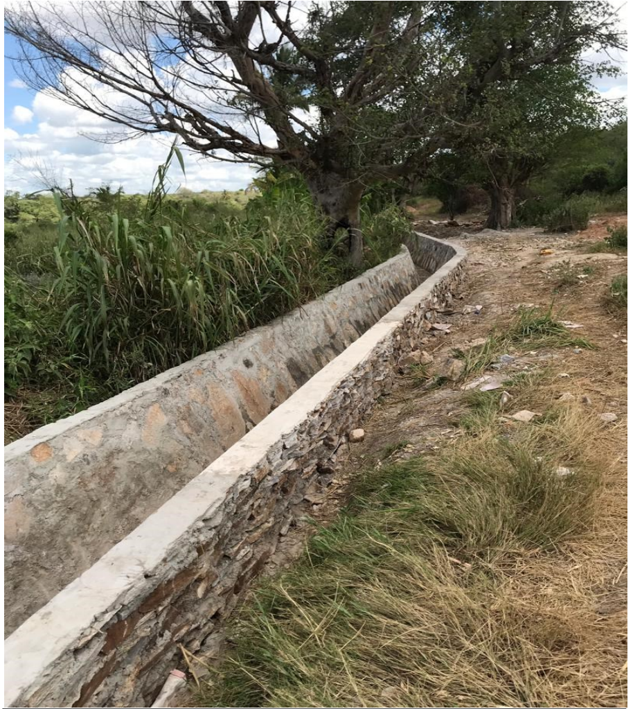
Sehemu ya mfereji mkuu wa umwagiliaji katika Kijiji cha Mabilioni wilayani Same mkoani Kilimanjaro ambao umejengwa na kusakafikiwa ( lining ) ambao hapo awali ulikuwa umejengwa kienyeji.
